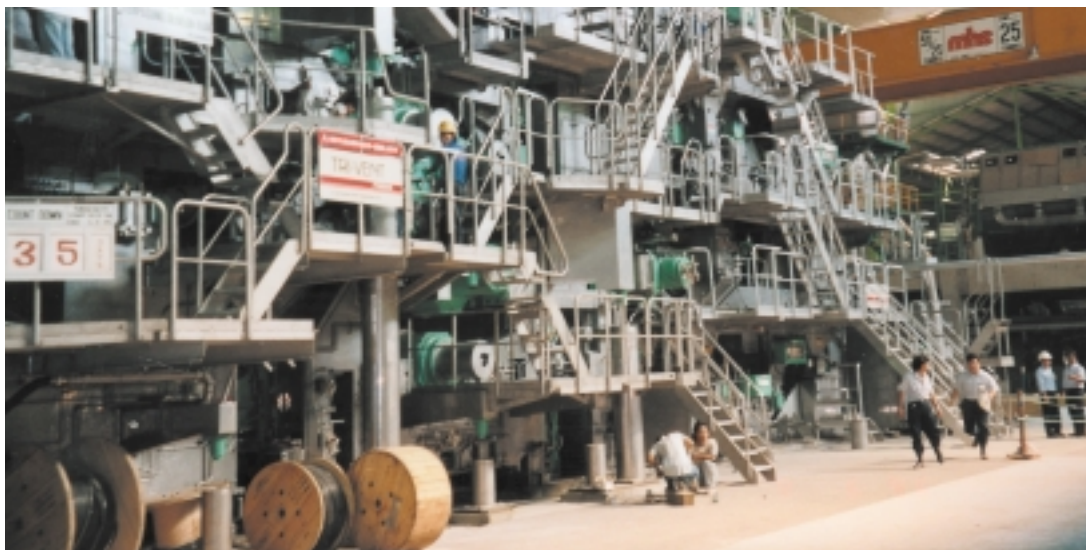
Teil der 500 Meter langen Papier-Produktionsstraße in Indonesien, die durch EAE Schaltschränke gesteuert wird.
